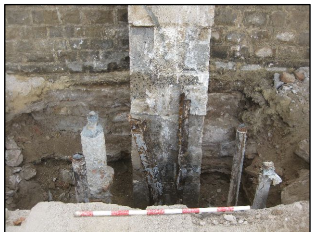
FOTO 20. Vista dels elements metàl·lics dels afegits contemporanis del contrafort 8.
