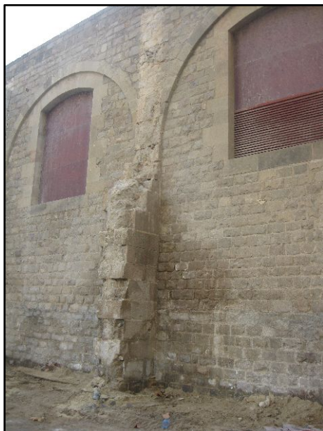
FOTO 15. Vista general del contrafort 4.
