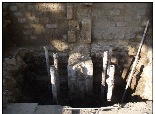
FOTO 8. Contrafort 5. Final excavació.
