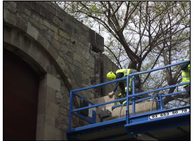
FOTO 2. Demolició manual de l'afegit modern.
