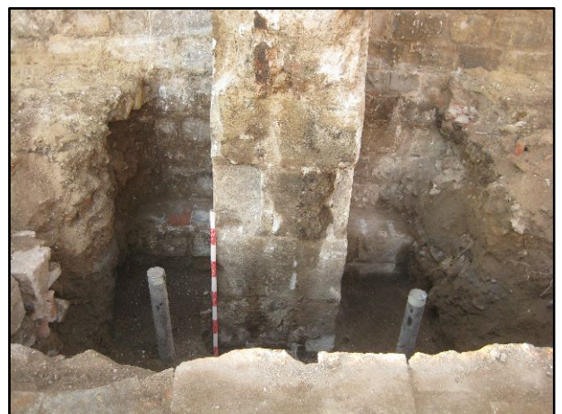
FOTO 16. Contrafort 4, final excavació.
