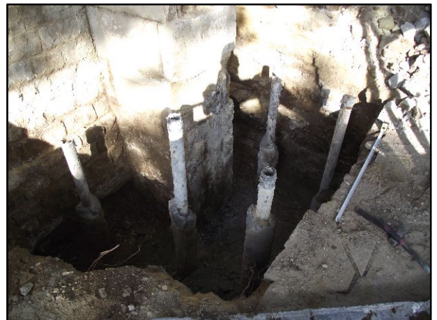
FOTO 12. Contrafort 9. Final excavació.
