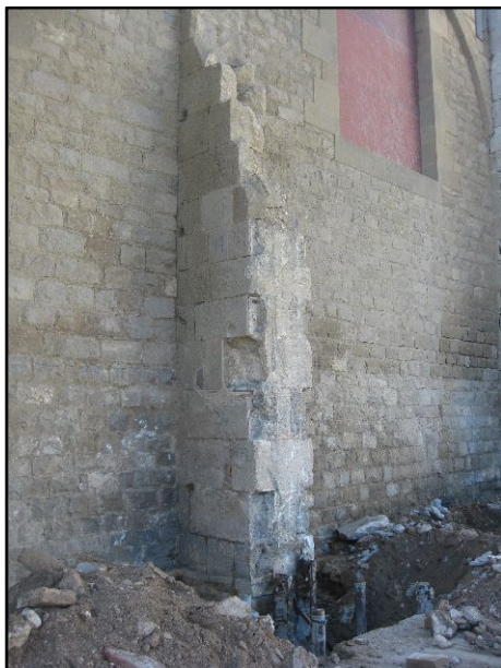
FOTO 19. Vista general del contrafort 8.
