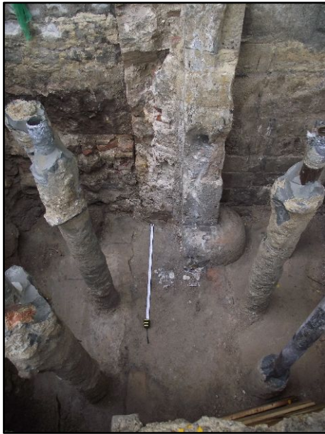
FOTO 5. Contrafort 1. Final excavació
