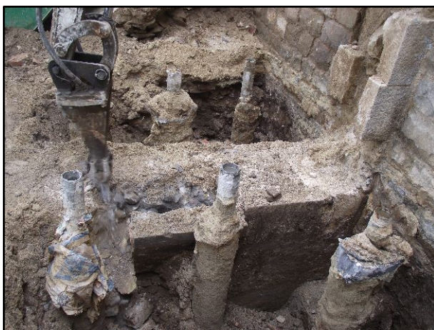
FOTO 7. Contrafort 5. Demolició fase contemporània.
